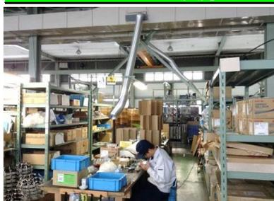
温風吹き出し口が高い場所にある為、アルミダクト等によって、天井付近から作業エリアの高さへ、より近くに暖房送風を送る事により、体感温度がUPし、暖房効果をUPさせた。
