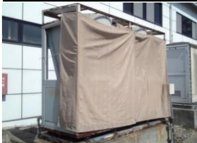
夏季において、事務所では空調用チラーでの冷房を行っている。チラー設定温度を調整し+3℃UPする事(8℃→11℃)、また外気温の影響で温度上昇を減らす為に日よけカバーの設置により、効率改善をしている。
