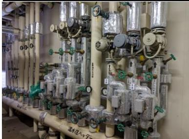
温水ボイラー用の循環冷温水配管の断熱化を行った。配管及び継手バルブからの放熱を抑制し保温、特に温水の熱効率をUPさせた。
