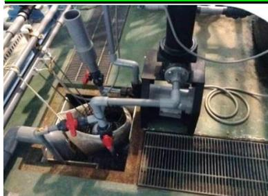
テスト水のリサイクルと同様となるが、ユニット製造工程において、テストに使用した水は排水ピットから排出せず、排水ピットから吸水する過機で循環させ、貯水槽に戻りリサイクルする。(自動制御)る過機及びポンプは当社製品を使用し、水使用量の削減を行っている。
