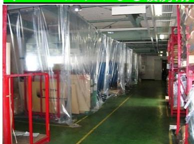
作業エリアと通路及び倉庫間等にビニルカーテンを設置し、各作業エリア内の暖房効率を改善した。また、窓ガラスへの断熱シート施工も行い、冬期間で約2~3℃の保温効果となった。
