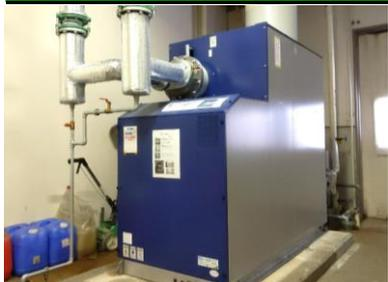
暖房ボイラーが各工場に3台、それぞれ稼働時間の管理を行い、より効率的・経済的に職場環境を整える。昼時間などにボイラーを停止し、その間は余熱での温水循環により対応し、灯油削減を行う。(断続運転での予熱利用など)
