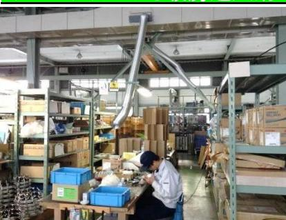
温風吹き出し口が高い場所にある為、アルミダクト等によって、天井付近から作業エリアの高さへ、より近くに暖房送風を送る事により、体感温度がUPし、暖房効果をUPさせた。
