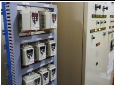
暖房ボイラ-用温水循環ポンプ及び送風ポンプ等へのインバ-タ設置。周波数を調整・制御し、よりムダの少ない効率的な運転及び最適な風量調整をすることで、大幅な節電効果につながっている。
