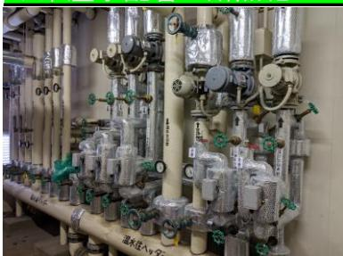
温水ボイラ-用の循環冷温水配管の断熱化を行った。配管及び継手バルブからの放熱を抑制し保温、特に温水の熱効率をUPさせた。
