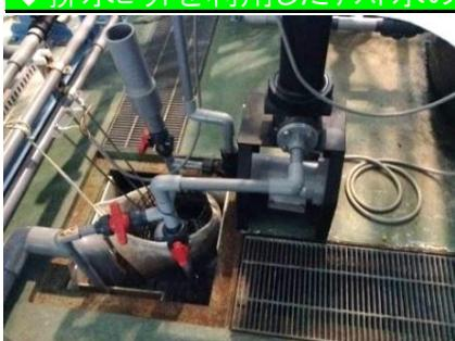
テスト水のリサイクル化と同様となるが、ユニット製造工程において、テストに使用した水は排水ピットから排出せず、排水ピットから吸水しろ過機で循環させ、貯水槽に戻しリサイクルする。(自動制御)ろ過機及びポンプは当社製品を使用し、水使用量の削減を行っている。
