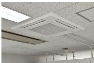
ボイラー・チラーの老朽化に伴い、設備更新(ボイラー・チラー更新orエアコン導入)の費用対効果を検証した結果をふまえ、灯油ボイラーを廃止して電気エアコンによる暖房への切替を実施した。
