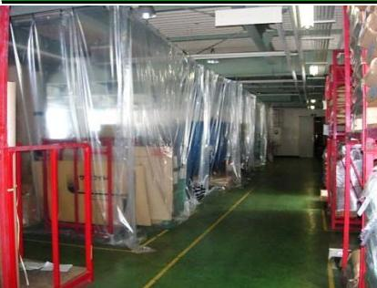
作業エリアと通路及び倉庫間等にビニールカーテンを設置し、各作業エリア内の暖房効率を改善した。また、窓ガラスへの断熱シート施工も行い、冬期間で約2~3°Cの保温効果となった。
