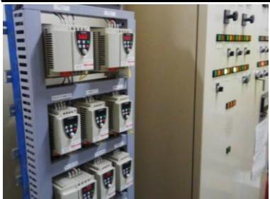
暖房ボイラ-用温水循環ポンプ及び送風ポンプ等へのインバータ設置。周波数を調整・制御し、よりムダの少ない効率的な運転及び最適な風量調整をすることで、大幅な節電効果につながっている。
